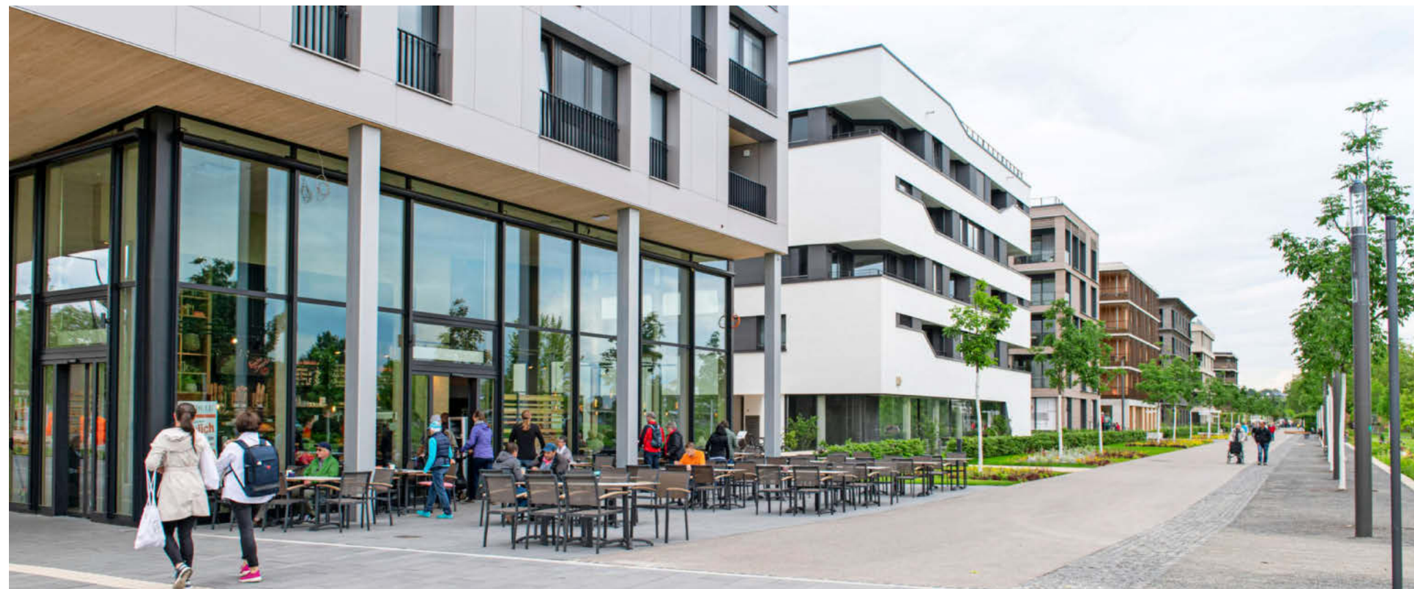
Die Stadtausstellung im Neckarbogen: Auf der Buga haben Bauherren schon ausprobiert, wie die Häuser und das Zusammenleben in der Zukunft aussehen könnten.
